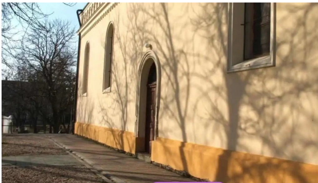
Var szig bau kft utolagos falszigeteles falszigeteles talajnedvesseg elleni szigeteles paks
