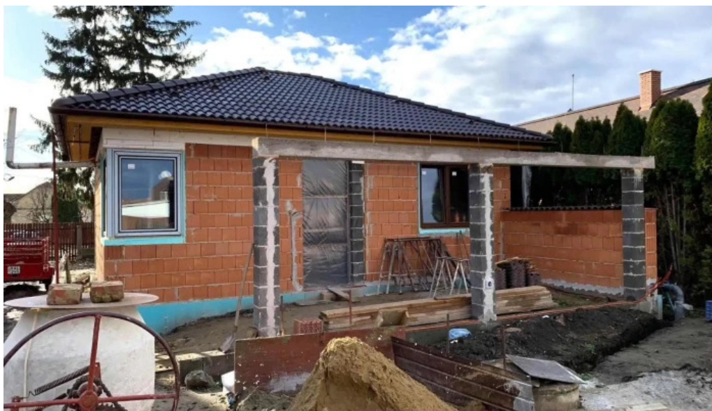
Hege ép kft. hőszigetelés, hajdu bihar vakolás, hajdu bihar szerkezet építés, hajdu bihar a tulajdonostól
