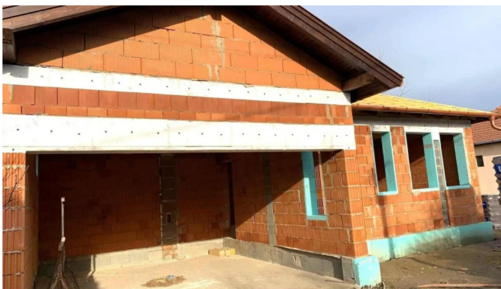
Hege ép kft. hőszigetelés hajdu bihar vakolás hajdu bihar szerkezet építés hajdu bihar külső
