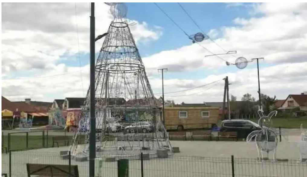
Tiszaújváros acélszerkezet építés szerencs
