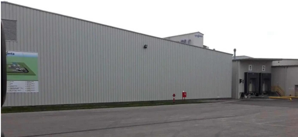
Mezoturi ipari park szerkezetlakatos
