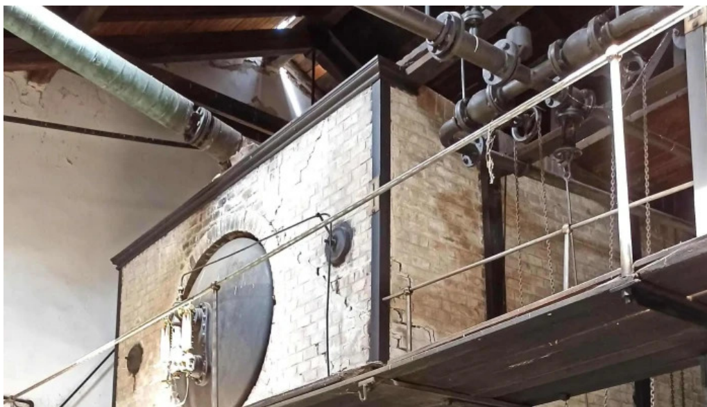
Gozuzemu szivattyutelep pontszám
