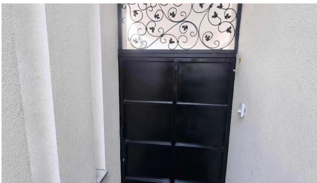
Welder face kft belül
