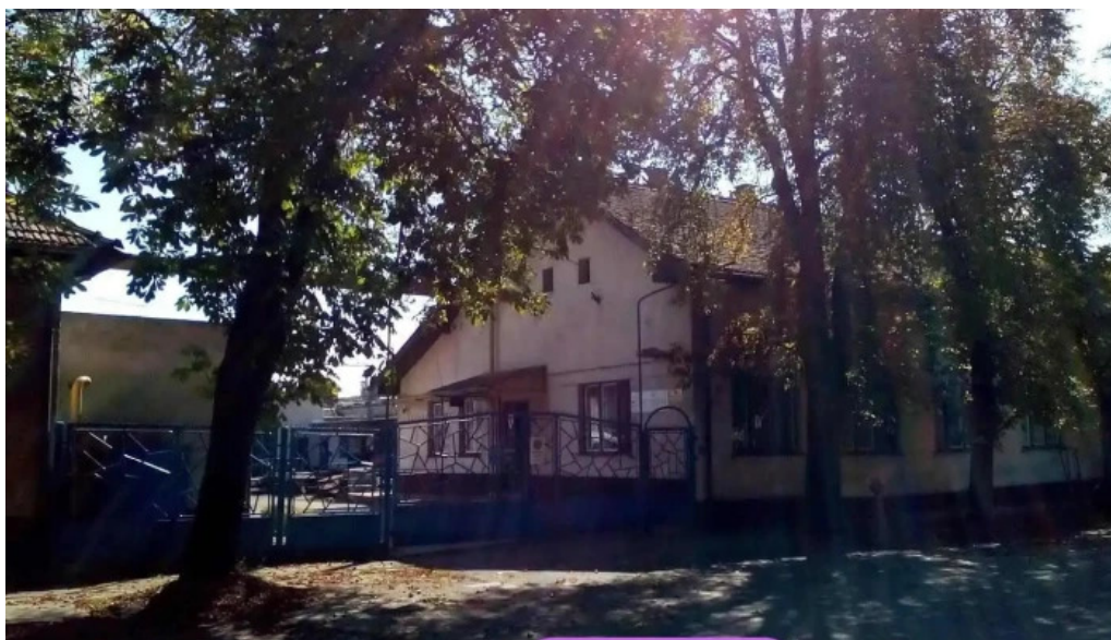
Kunferr kft acelszerkezet acelszerkezet gyartasa acelszerkezet ertesitese kisujszallas
