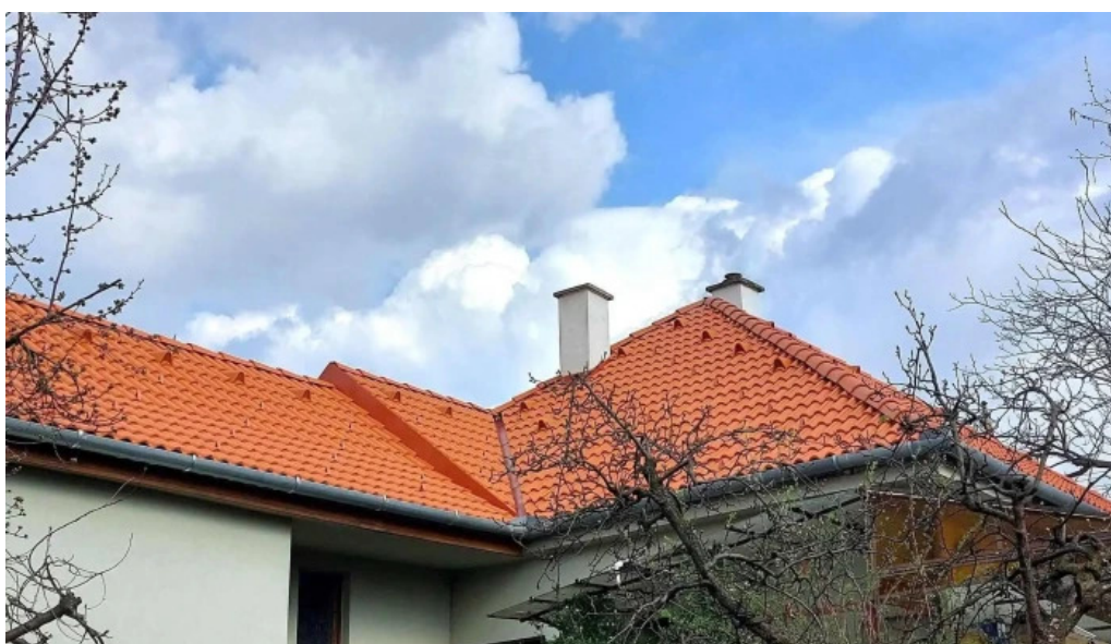
Acsolunk építőipari kft építőipari vállalkozás
