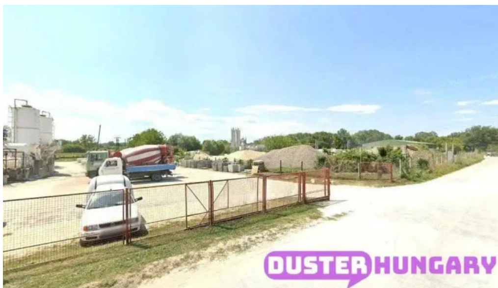
Koko beton kereskedelmi kft dombovar
